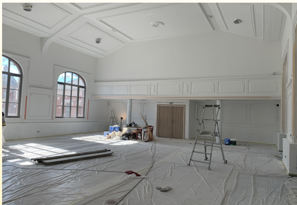
Le plafond et les murs sont en préparation avant la pose de la peinture dans la salle principale.
