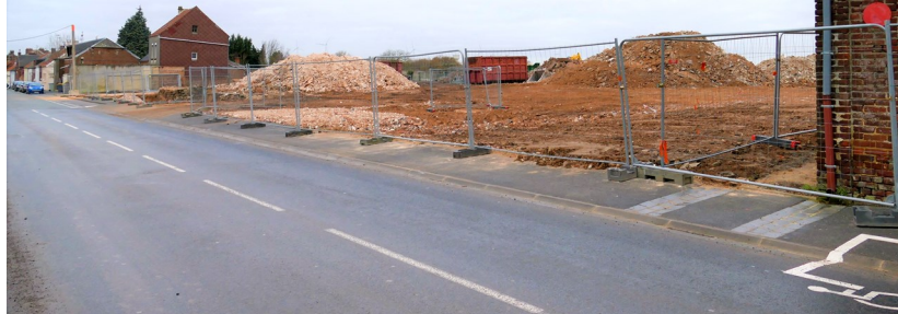
Friches. Les travaux de démolition du site SFM de la rue Henri Barbusse se terminent. Les anciens bâtiments viennent d'être démolis.
