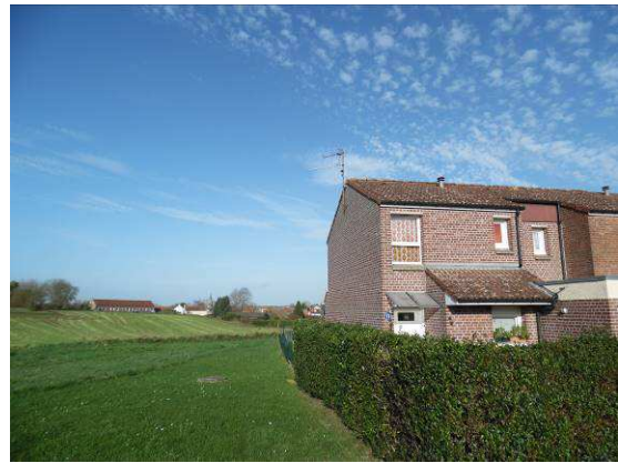
Vue sur le site depuis la dernière construction rue Jacques Duclos
