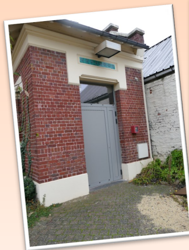
Pose des nouvelles menuiseries.
