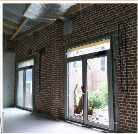
Pose des nouvelles menuiseries.
