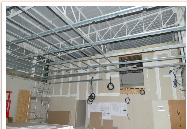
Cloisonnement et isolation des murs de la salle annexe.
