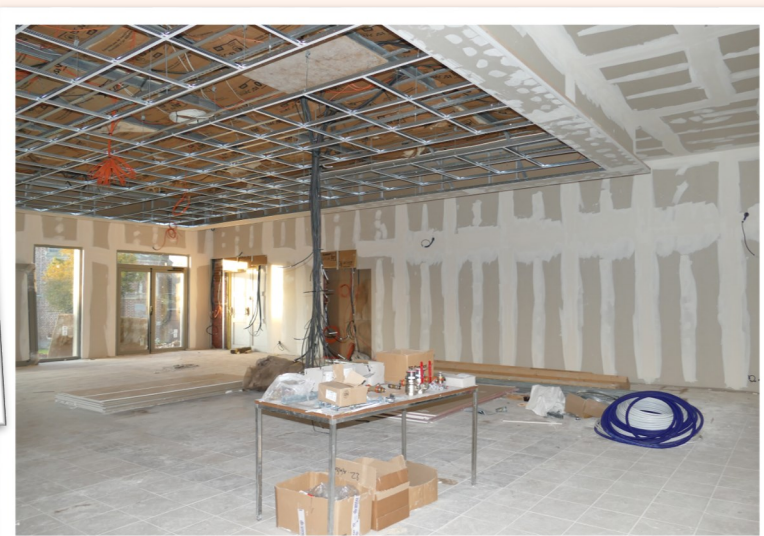
Cloisonnement, isolation et passage de câbles électriques dans la salle annexe.
