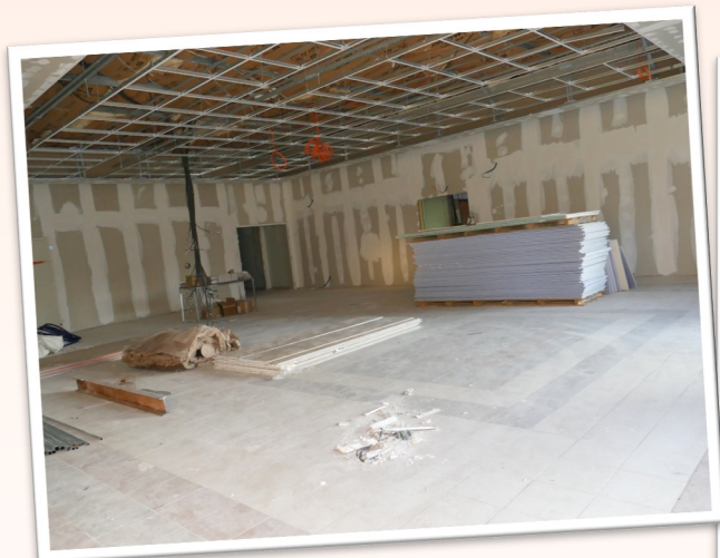
Cloisonnement, isolation et passage de câbles électriques dans la salle annexe.
