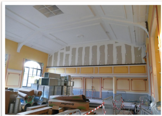
Cloisonnement, isolation et passage de câbles électriques dans la salle annexe.
