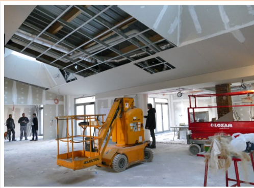
Isolation et cloisonnement avec passage des gaines dans la véranda.
