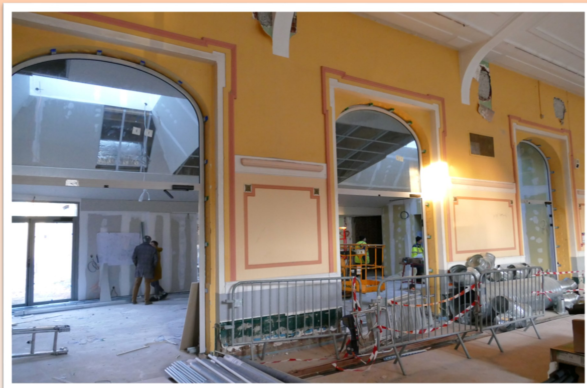
Vue de la salle principale sur l'ancienne véranda et les nouvelles menuiseries posées aux arches.
