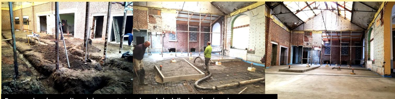
Passage des réseaux d'assainissement et coulage de la dalle dans la véranda
